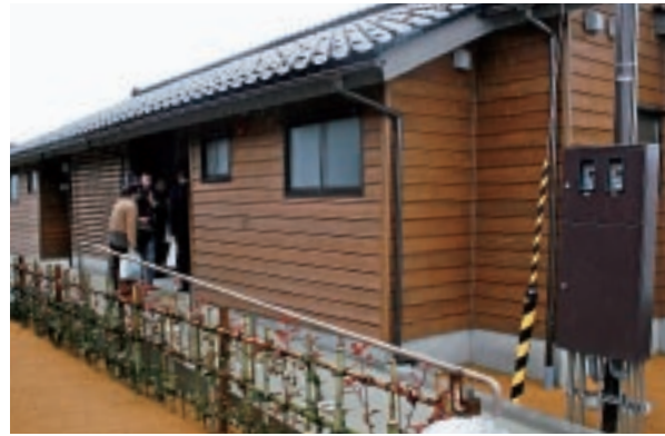
完成第1号となった災害公営住宅＝平成21年2月25日、輪島市門前町道下
