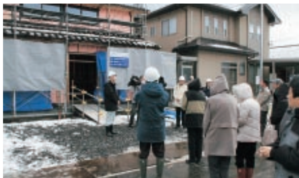
建設中のモデル住宅の見学会を開催＝平成20年1月27日
