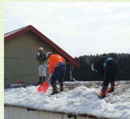
地域住民による屋根の雪下ろし
