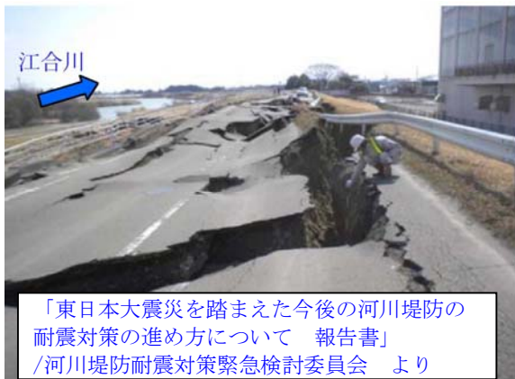
河川堤防：液状化で崩壊、越水個所の決壊
