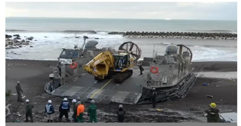
国土交通省の重機等を揚陸
