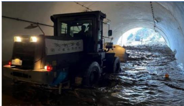
道路啓開作業
