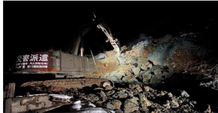
夜間の道路啓開作業
