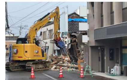
珠洲市内での緊急解体（2月下旬）
