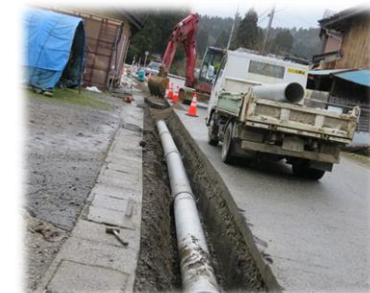
仮設の水道配管工事 (送水管の延長)
