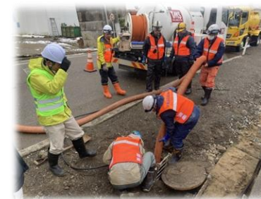
下水道管内の清掃
