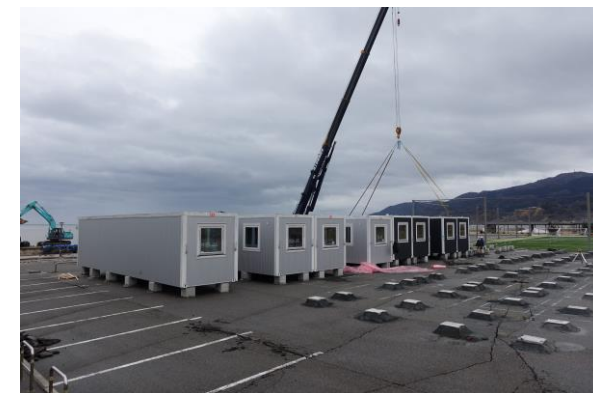
応急仮設住宅建設
