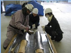
鉛瓦の施工
