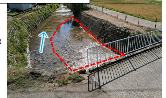
鍋谷川（R4.8豪雨 被災河川）：堆積土砂除去状況
