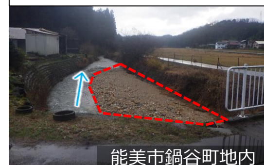
鍋谷川（R4.8豪雨 被災河川）：堆積土砂除去状況
