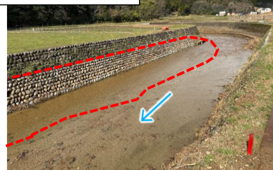
能瀬川（R5.7豪雨 被災河川）：堆積土砂除去状況
