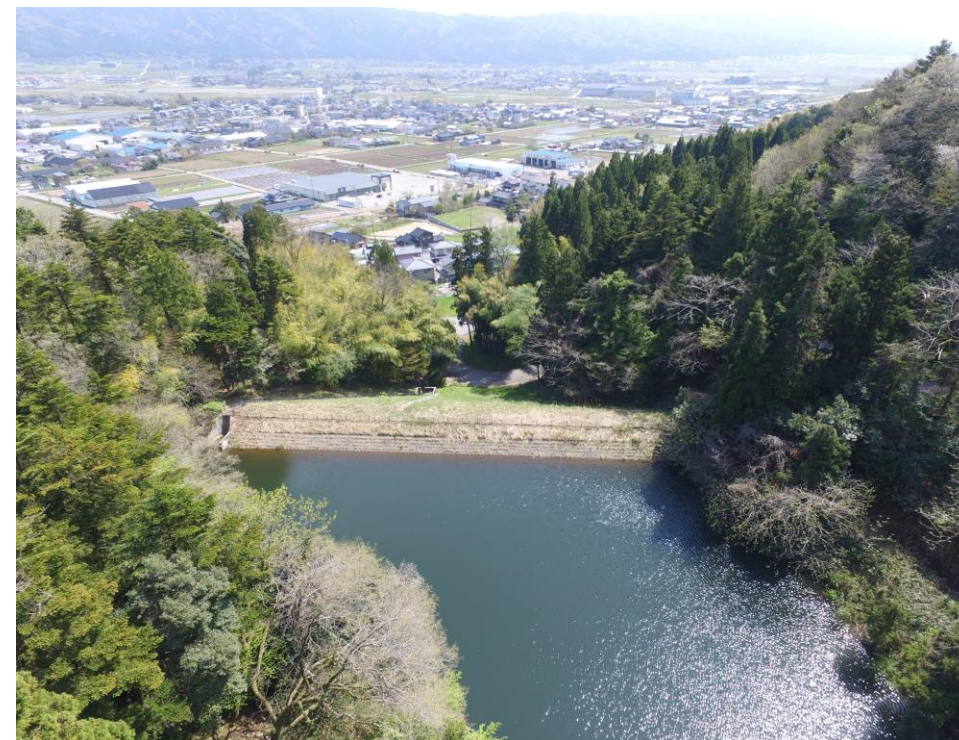
防災重点農業用ため池 第1山池（中能登町良川）
