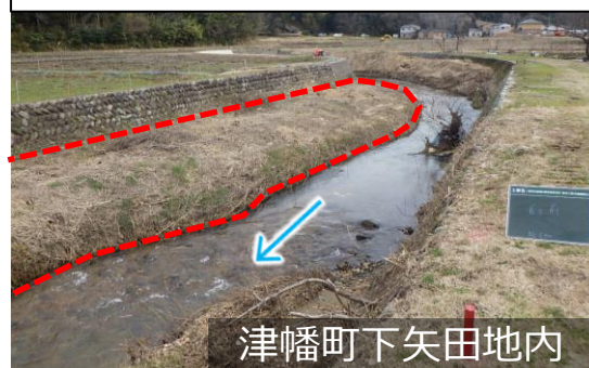
能瀬川（R5.7豪雨 被災河川）：堆積土砂除去状況
