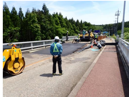
すりつけ舗装施工中
