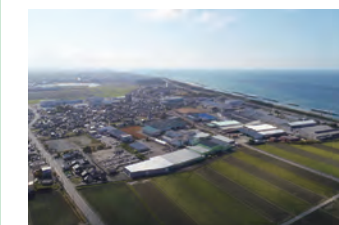
鹿島工業団地
