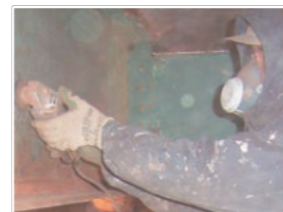
▲事後保全型補修(全塗装補修)
