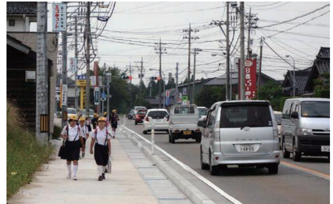
▲国道249号(志賀町高浜) (歩道の整備)
