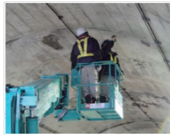
▲近接目視による点検
