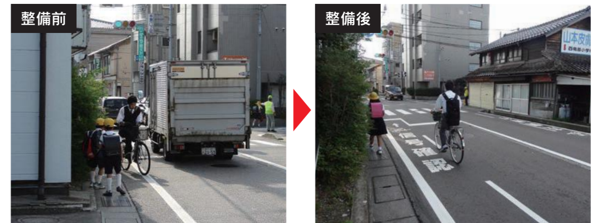
▲一般県道 倉部金沢線(金沢市西泉) (自転車走行指導帯の整備)
