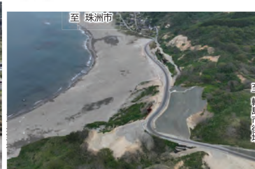
写真③ 応急復旧道路
