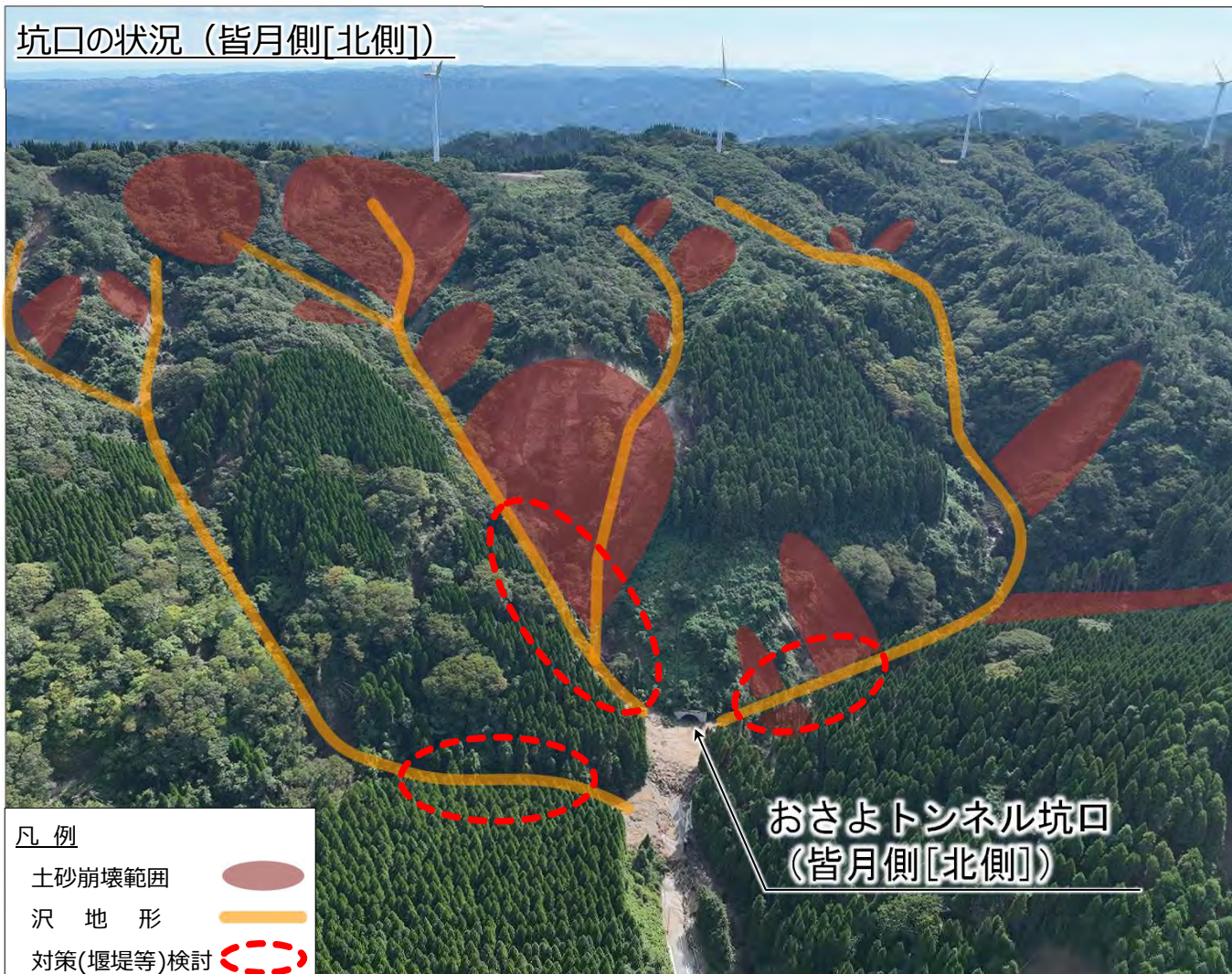
豪雨後の状況
