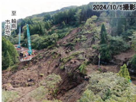
写真① 土砂流出状況
