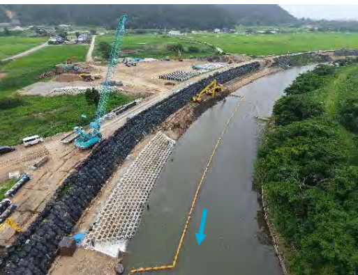
河川護岸の本復旧状況(町野川)
