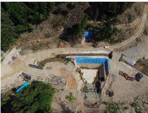
砂防堰堤の施工状況(寺地川)
