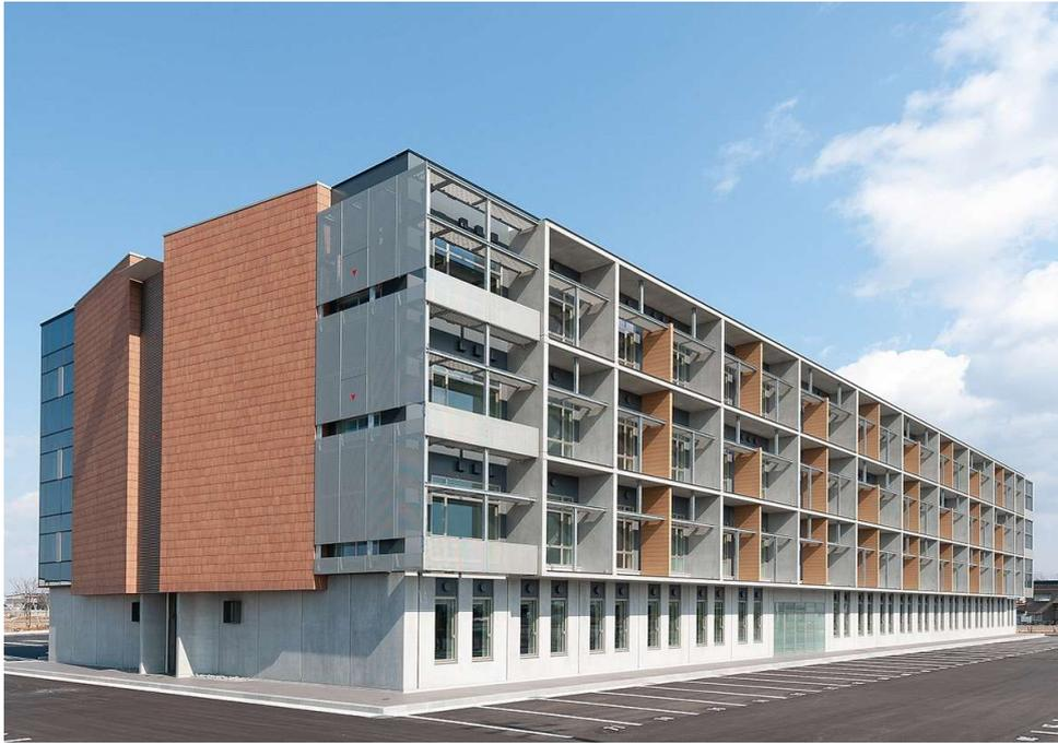
**配置計画：** 本建築は、執務空間を主とした東西に長い庁舎棟と車庫や倉庫を主とした南北に長い車庫倉庫棟をL型に配し、日射による熱負荷に対して有利な配置・形状としている。
