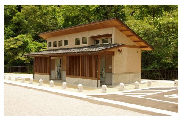
比丘尼沢ポケットパークに設置された公衆便所で、地形上日当たりが少ないため、採光が十分 取れるように吹き抜けを設置し、高窓から採光がとれるように配慮した。木材はできるだけ県産 材を使用し、内装・外装の一部を輪島産の能登ヒバ仕様とした。
