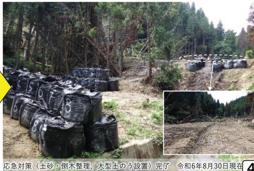
応急対策 (土砂・倒木整理、大型土のう設置) 完了 令和6年8月30日現在
