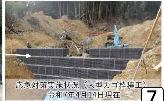
応急対策実施状況 (大型カゴ枿積工)
