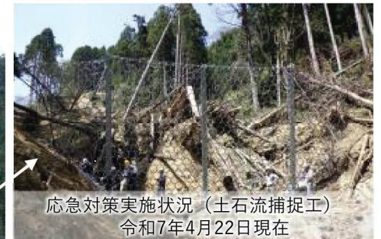
応急対策実施状況 (土石流捕捉工)
