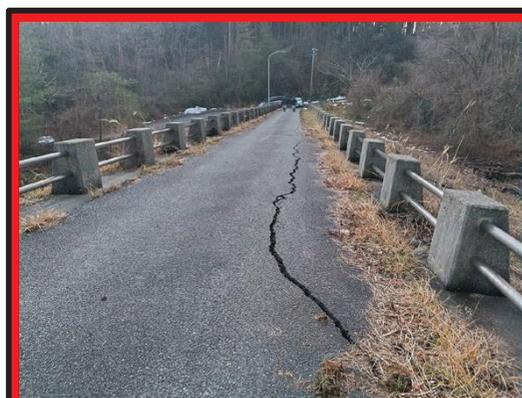
写真① ダム堤体の亀裂 (石川県珠洲市)
