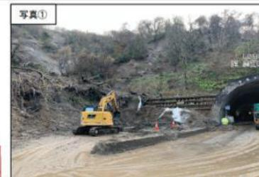
写真① 中屋トンネル(輪島市街地側坑口)の土砂撤去状況(R6.12)
