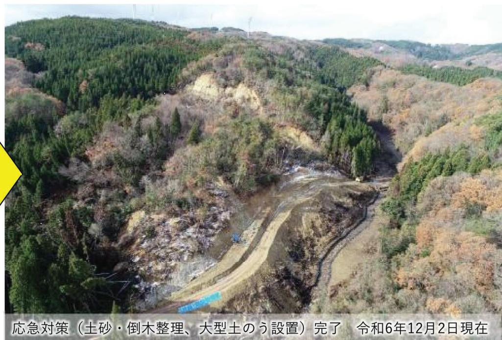
応急対策 (土砂・倒木整理、大型土のう設置) 完了 令和6年12月2日現在
