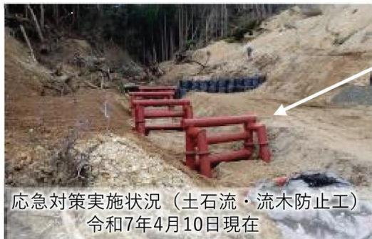
応急対策実施状況 (土石流・流木防止工)
