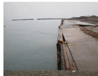
岸壁のズレ、岸壁背後の沈下
