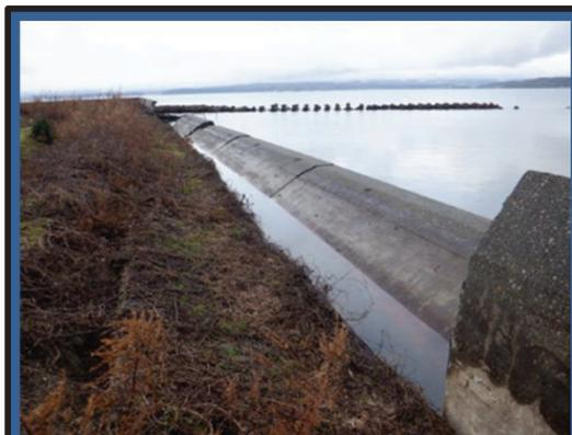
写真③ 海岸護岸の倒伏 (石川県七尾市)
