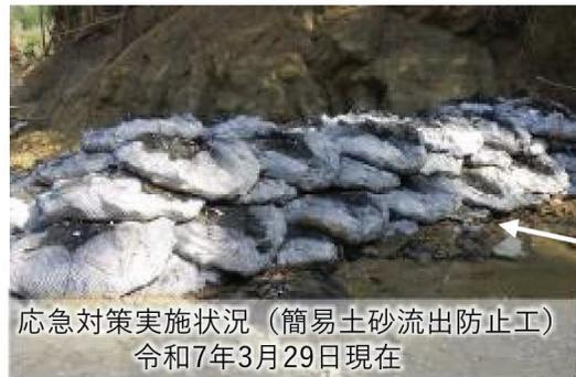
応急対策実施状況 (簡易土砂流出防止工)
