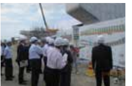
金沢外環状道路海側幹線を視察し、橋梁下部の工事について説明を受けました
