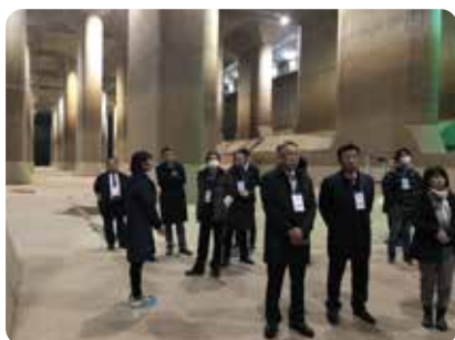
台風19号による豪雨でも洪水対策に機能を発揮した 首都圏外郭放水路を調査 (埼玉県春日部市)
