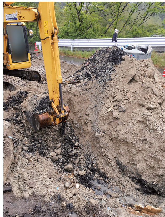
不適正処理の防止(廃棄物の撤去による原状回復)
