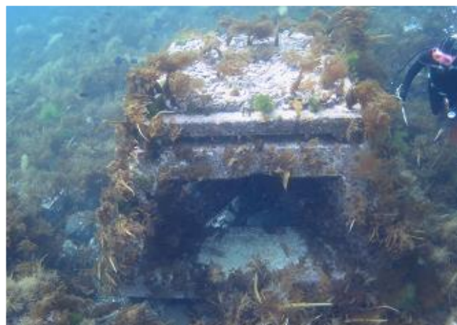
令和4年6月調査（設置後3年）
