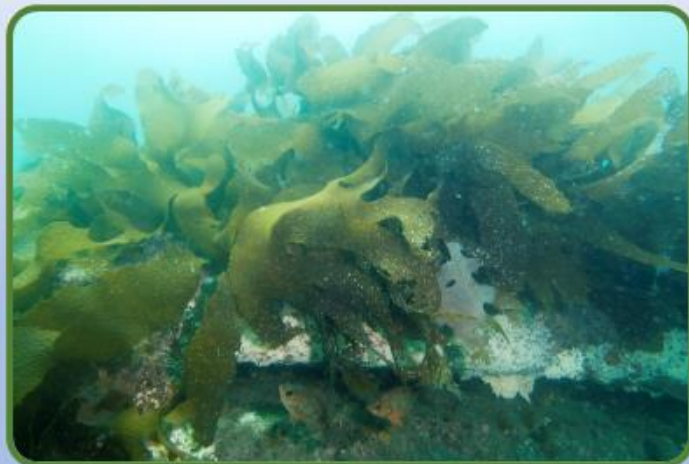
海中に設置した藻場造成ブロックの様子
