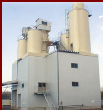
焼却灰プラント
