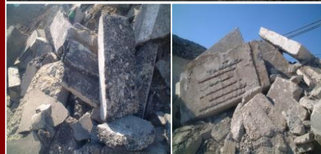
がれき類 (アスファルト塊)
