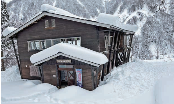
写真1 2022年12月下旬の観察舎外観
