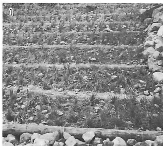
丸太土留工・植生ブロック移植
