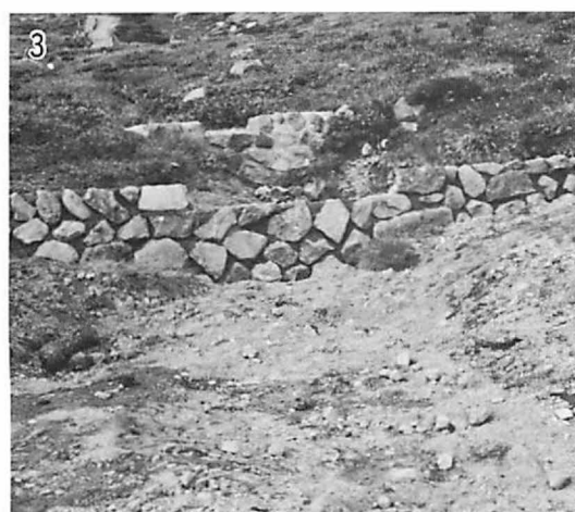
練石積土留工
