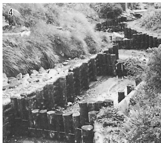
木柱土留工・丸太積設岸工
