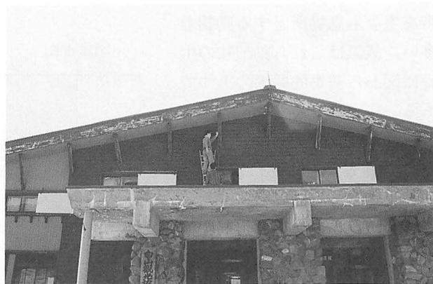
写真2 室堂ビジターセンターに温度センサーを設置しているところ
