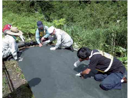
防草シートによる対策の様子
