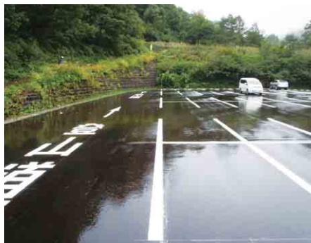
舗装後の別当出合駐車場
