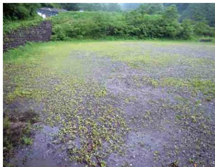
舗装前の別当出合駐車場
