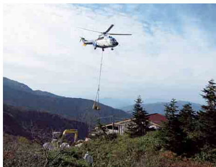
ヘリコプターによる山小屋の建築資材の搬入
