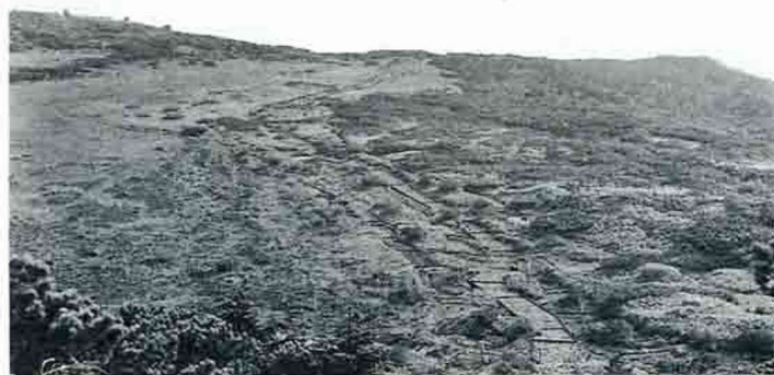
弥陀ヶ原登山道 整備工事後 (昭和55年)
