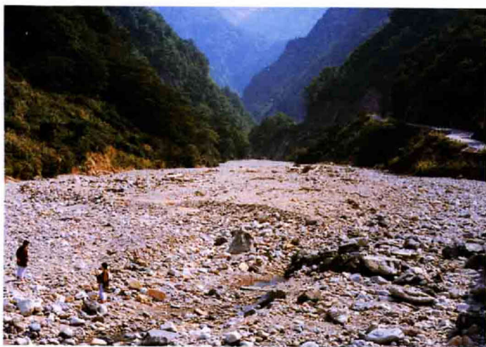
流れの干上がった砂防ダムの上流
