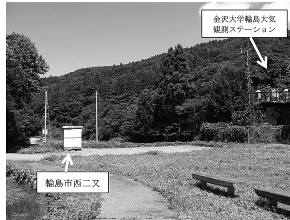
図 2 輪島市西二又の周辺状況
