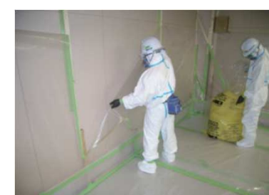
養生シートの撤去
