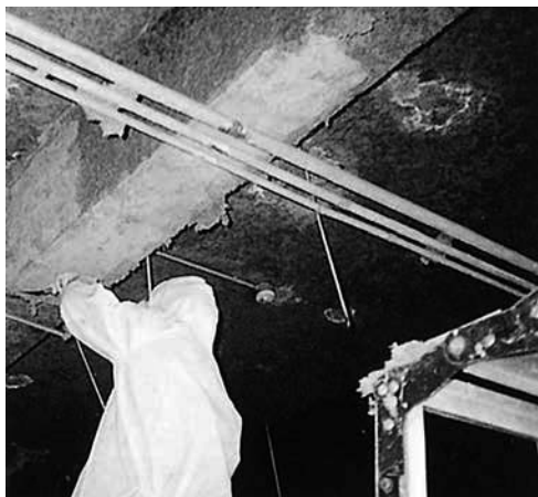
吹付け石綿の除去
