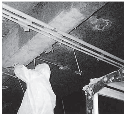
吹付け石綿の除去
