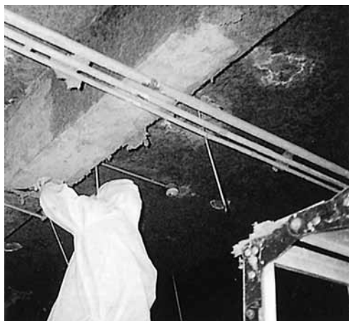
吹付け石綿の除去
