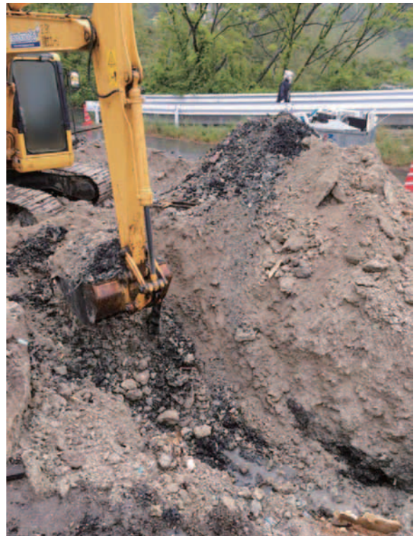
不適正処理の防止（廃棄物の撤去による原状回復）
