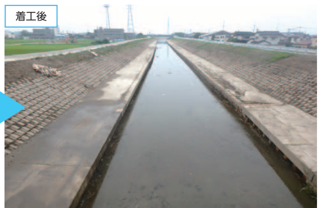
金腐川漆橋（下流）の堆積土砂除去
