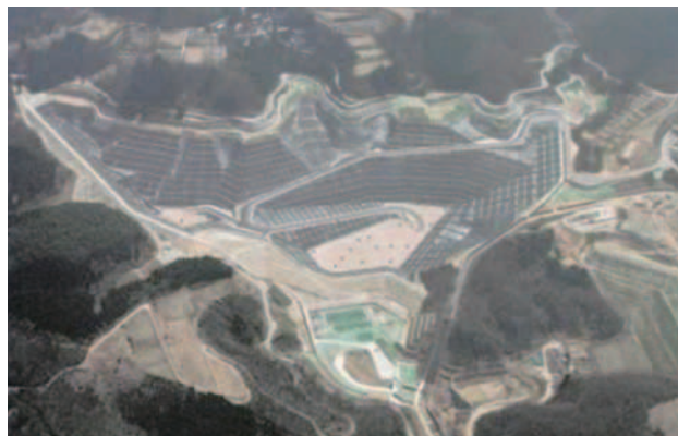
一般廃棄物最終処分場
