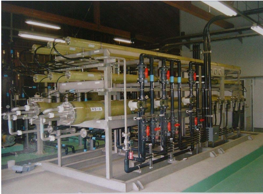
舳倉島簡易水道浄水場逆浸透膜ユニット(写真提供:輪島市)
