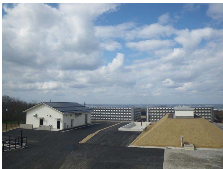
南部配水場(写真提供:羽咋市)
