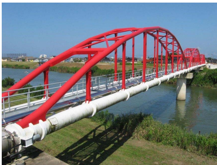
天神水管橋(写真提供:小松市)
