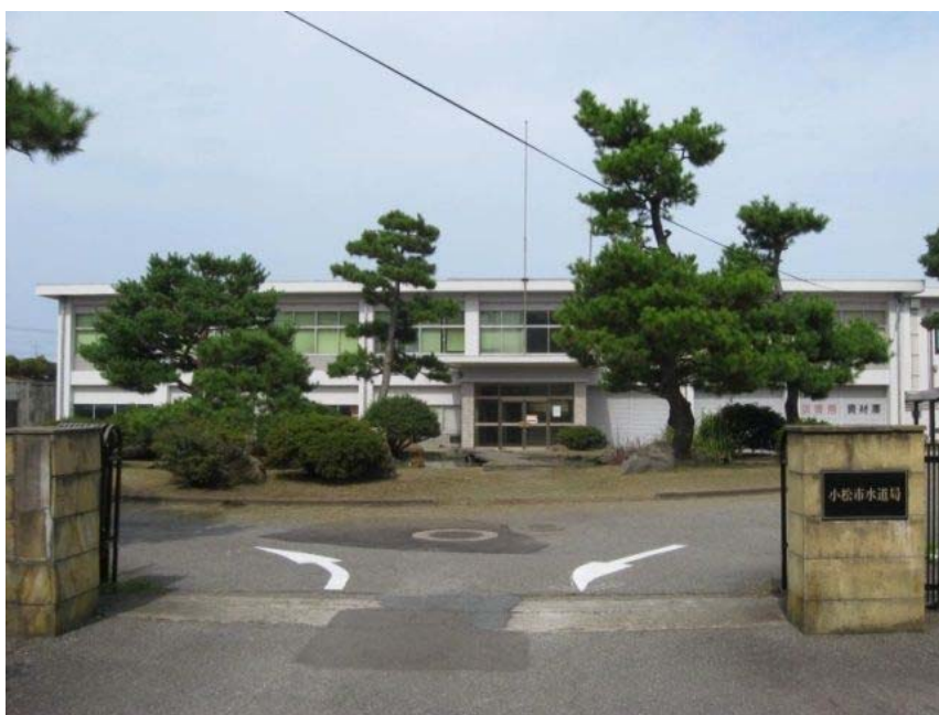
丸の内配水場(写真提供:小松市)
