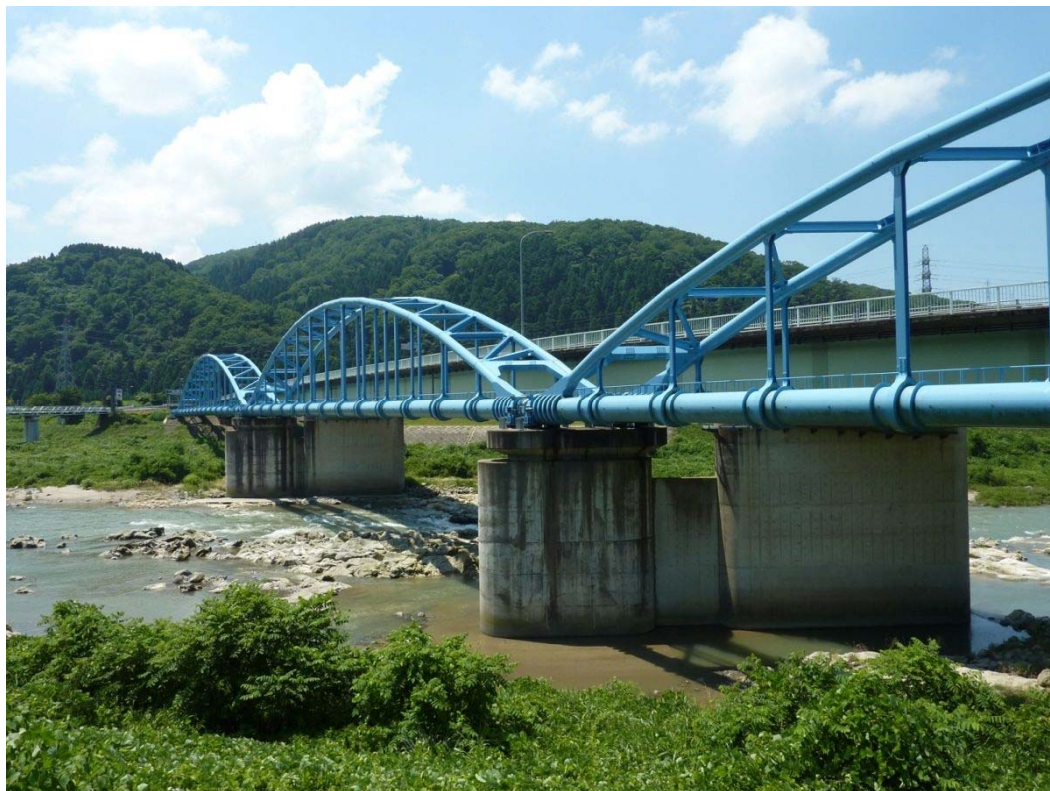
水管橋(写真提供:石川県水道企業課)
