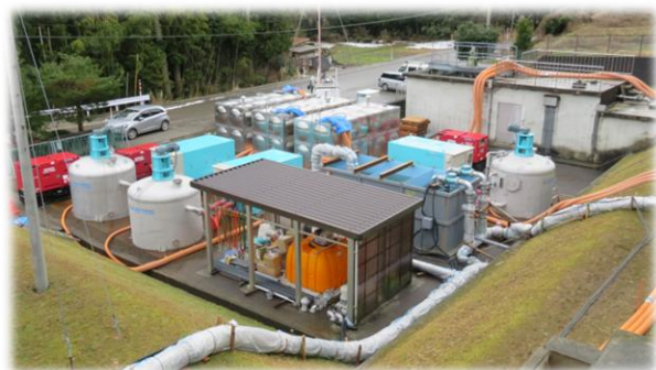
仮設の設備工事 (珠洲市・宝立浄水場の機能回復)
