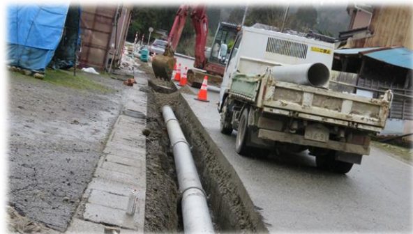
仮設の水道配管工事 (送水管の延長)
