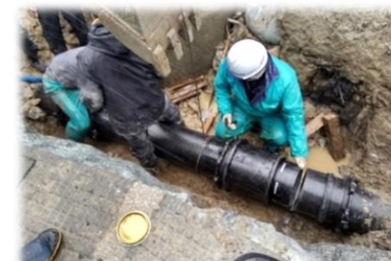
水道管の復旧作業 (輪島市内)
