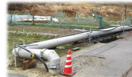
仮設水道管の設置 (珠州市内)
