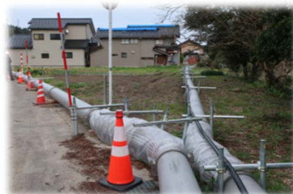
仮設水道管の設置 (珠洲市内)
