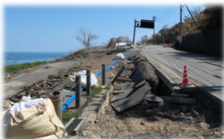
仮設水道管の設置 (輪島市内)
