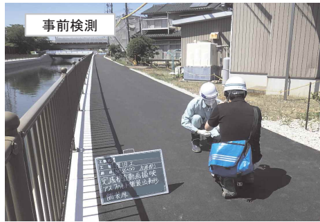
竣工検査をリモートで実施 (完成図書はクラウド上で確認、出来形は事前に発注者で検測等の工夫を実施)
