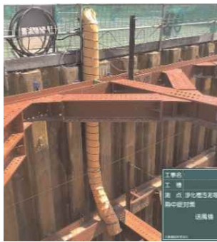
送風機により通気性を確保するとともに、ドライミスト発生装置等も併用
