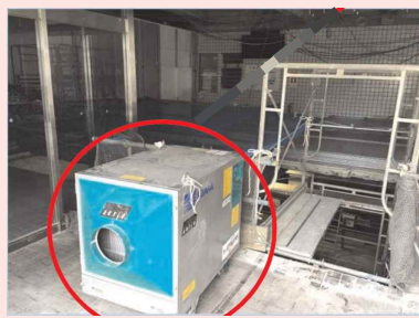
集塵機を設置し室内の換気を実施
