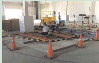
工事エリアの区画を設定して作業
