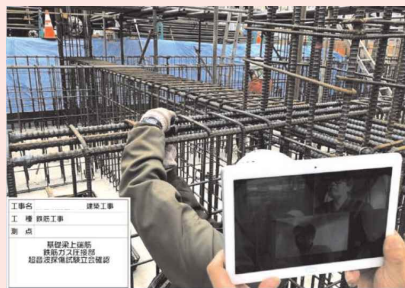
Webカメラを利用した遠隔検査
