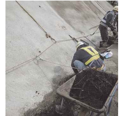
作業時なるべく離隔を確保
