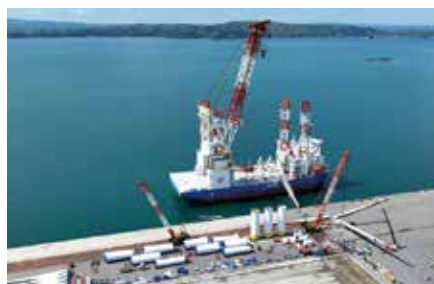
洋上風力発電設備取扱い状況
