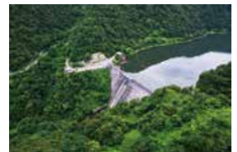
犀川ダム（金沢市）
