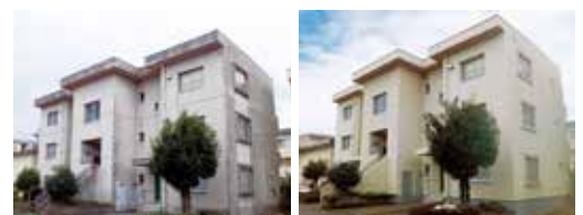
改修前 改修後 円光寺町団地(整備写真)(令和5年2月完成)
