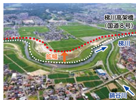
梯川（国道8号付近の拡幅）
