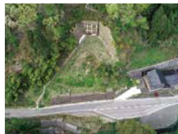
対策後の状況 (令和3年5月)
