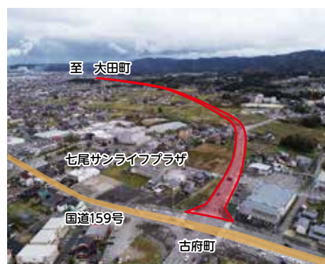
七尾外環状道路((都)外環状線)
