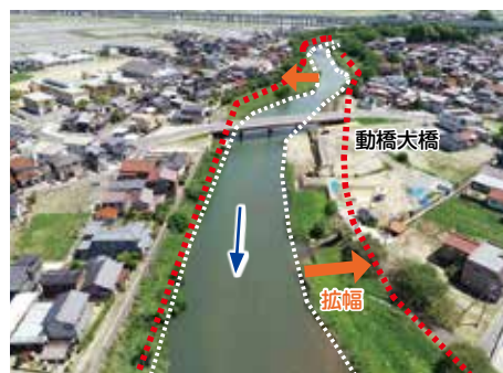
動橋川（動橋大橋付近の拡幅）
