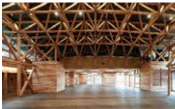
構造・内装材に木材を使用 (奥卯辰山健民公園管理センター)
