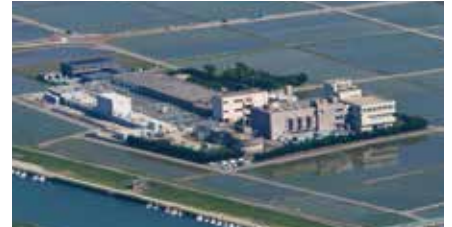
②公共下水道 中央浄化センター（小松市）
