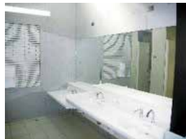
カウンター式洗面器の設置
