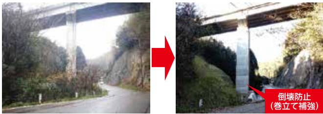
主要地方道志賀富来線 志賀町福浦港地内（水の潤橋）
