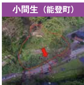
災害状況 県道破損 (平成29年10月23日)
