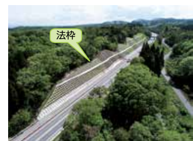
法面落石対策((主)七尾輪島線)
