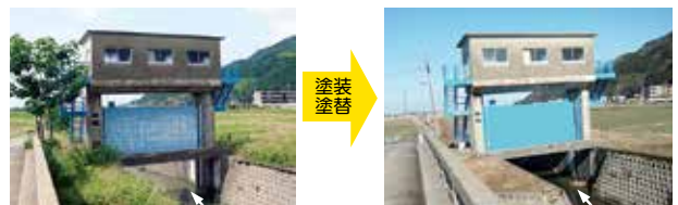
扉体の腐食防止対策
