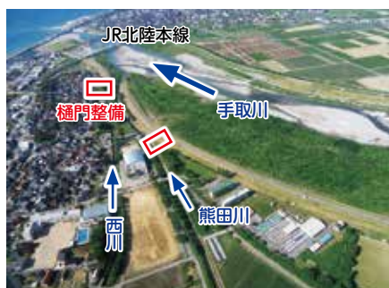
手取川（河口付近の樋門整備）
