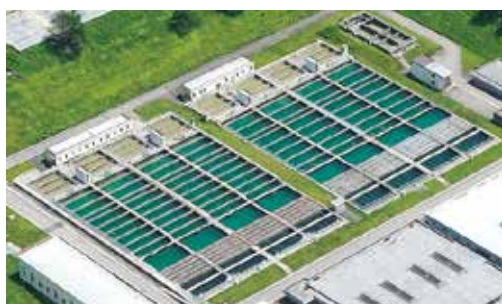
着水井、急速混和池、フロック形成池、沈でん池
