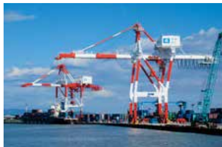
御供田国際コンテナターミナル（2基のガントリークレーン）
