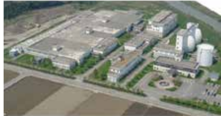
①流域下水道 犀川左岸浄化センター
