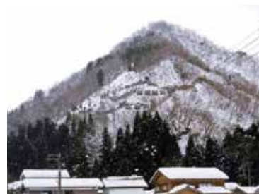
対策後の状況 (平成13年2月)
