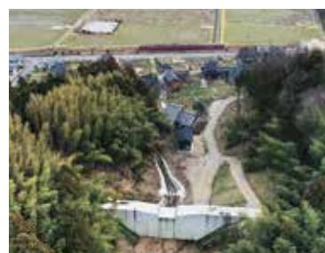
対策後の状況 (平成31年3月)
