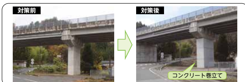
橋梁耐震補強((国)249号)
