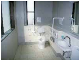
多目的トイレの整備
