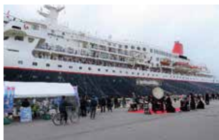
矢田新耐震強化（旅客船）岸壁（クルーズ船：にっぽん丸）
