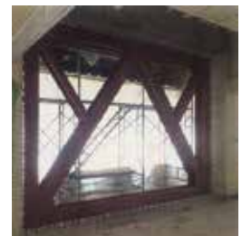
耐震ブレース設置中の様子
