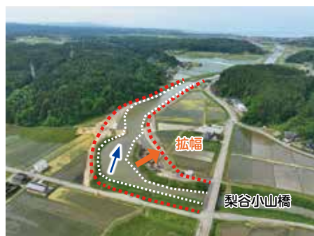
米町川（梨谷小山橋付近の拡幅）
