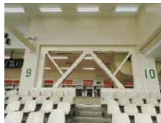
耐震ブレースの設置(金沢競馬場)
