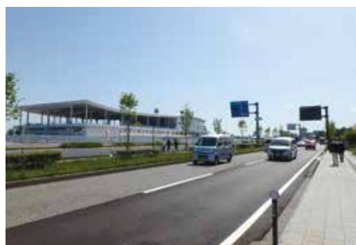
整備後 (令和5年4月完成)
