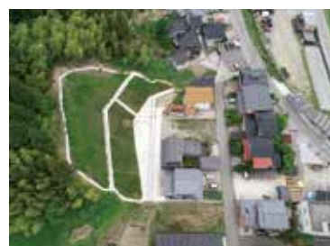
対策後の状況 (令和2年6月)
