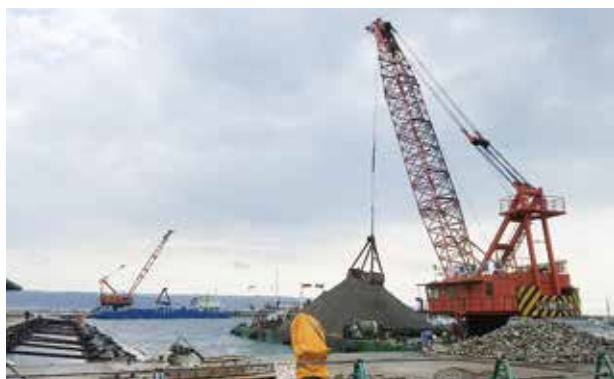
港湾工事作業状況
