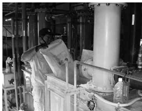
破壊装置に中和剤投入作業
