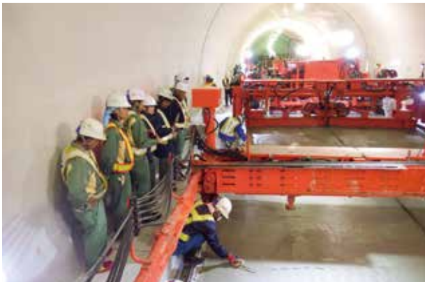
トンネル内での現場研修
