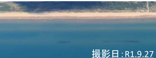
・人工リーフ(羽咋地区) 実施期間: 平成27年~
