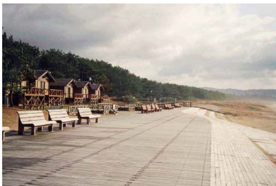
ボードウォークにより景観上の配慮がなされている(平成12年12月5日撮影)
