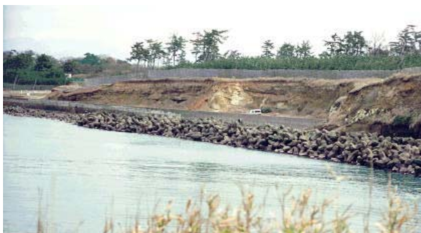
崖が崩壊している片山津海岸(尼御前岬)
