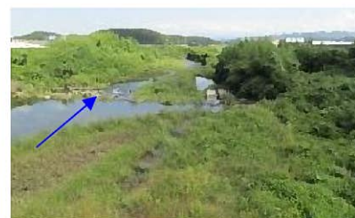
堆積状況 動橋川 (加賀市)
