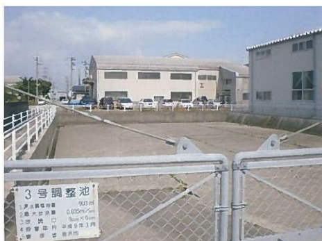
雨水貯留施設(調整池)
