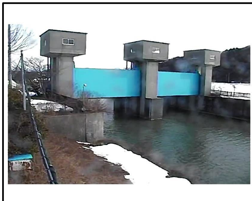
三谷川 下福田逆水門
