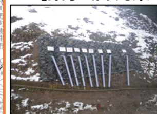
対策事例: 地上での水抜きBo
