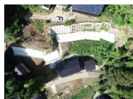
対策事例：法枠工
