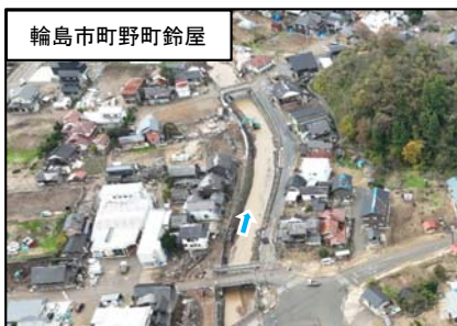
土砂流出による氾濫
