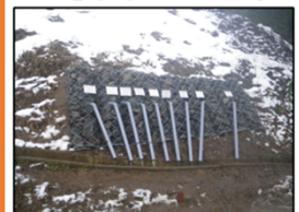
対策事例：地上での水抜きBo
