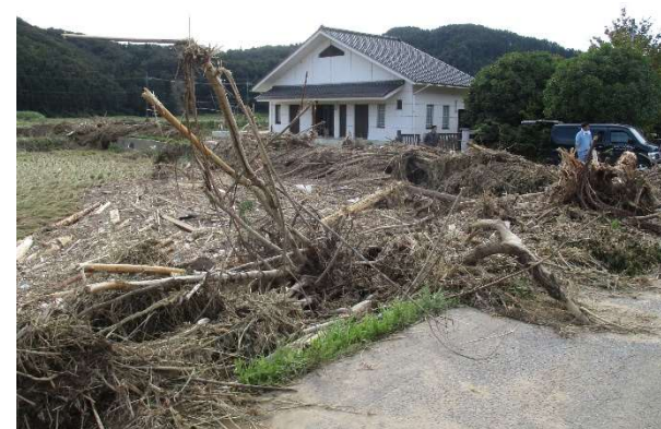
浸水した小間生処理場
