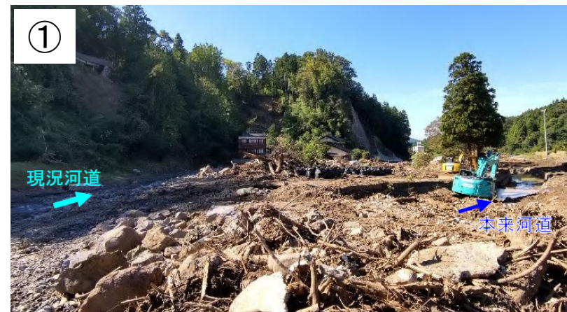
下流集落付近に土砂・流木が広く堆積
