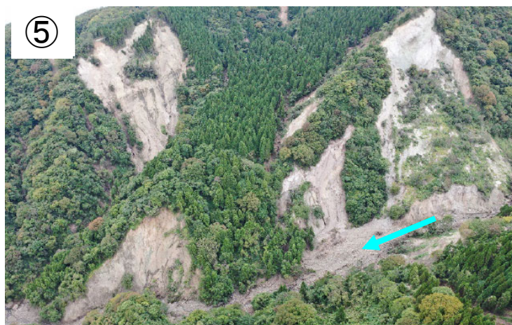
上流部では大規模な斜面崩落、継続的に土砂流出が発生するおそれあり
