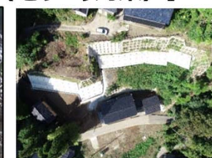
対策事例: 法枠工
