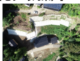
対策事例：法枠工
