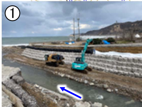
応急復旧状況
