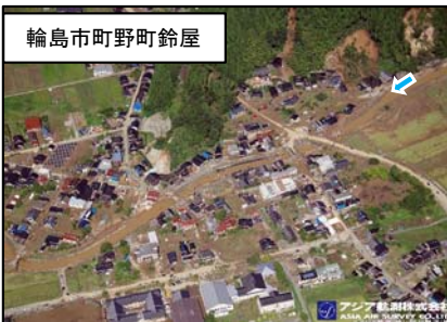
土砂流出による氾濫
