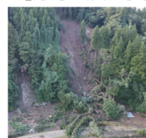
整備前（山腹崩壊）
