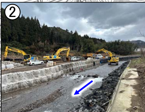
応急復旧状況
