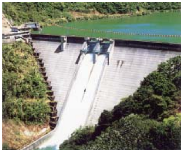
犀川ダム全景
