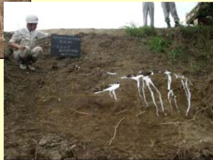
石膏を注入し、穴の探索・追跡調査
